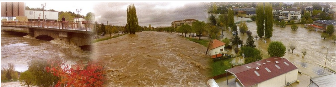
Photo de la crue de 2008 à Lozanne (source : mairie de Lozanne)
