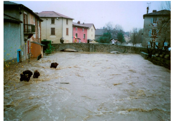
Photo de la crue du Garon en 2003 à Brignais, Pont Vieux (source : SMAGGA)
