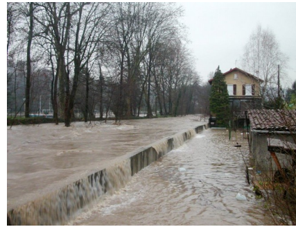
Exemple de petits endiguements au Merlo à Sainte-Foy-lès-Lyon lors de la crue de 2003 (source :SAGYRC)
